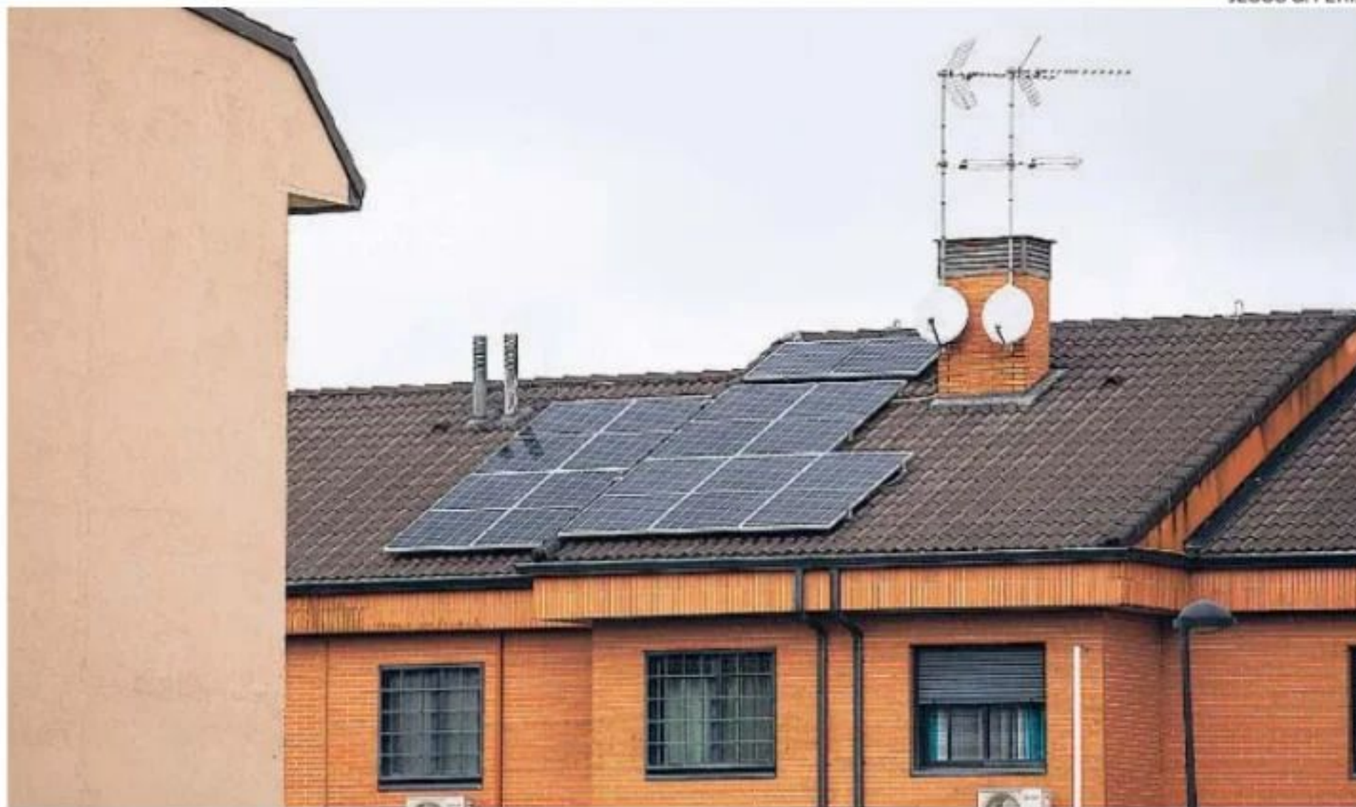
Instalaciones de autoconsumo en una vivienda
